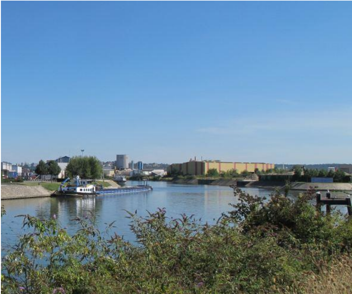
Vue sur les bâtiments du futur Centre de Tri Mécanisé de Déchets de Chantier de Bonneuil-sur-Marne
