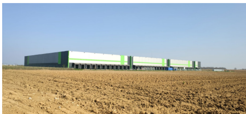
Entrepôt de logistique bâti sur des terres agricoles à Brie-Comte-Robert ©MRAe 2023
