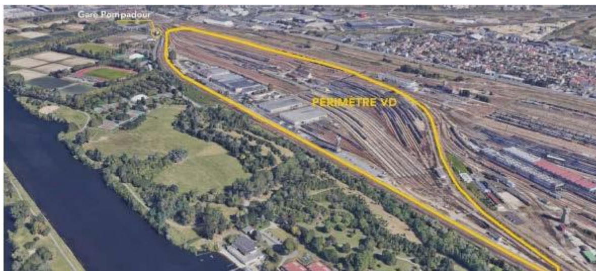
Figure 1 : Vue aérienne du site (source : dossier)
