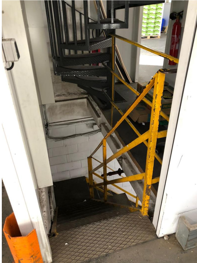
Cage d'escalier entre le sous-sol et le rez-de-chaussée de l'entreprise Lliso Frères
