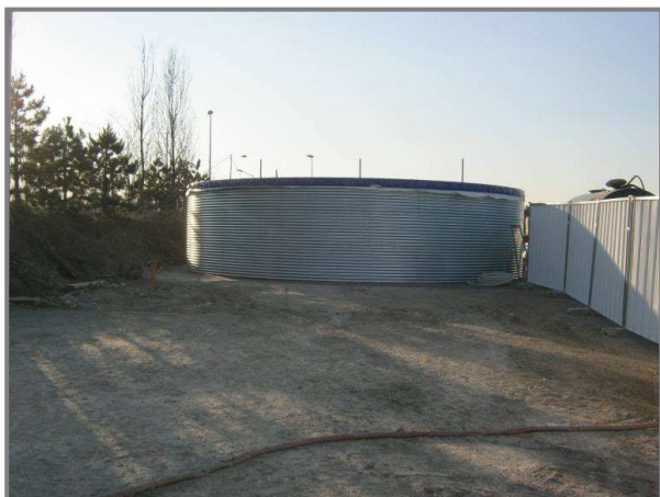
▲ Cuve de stockage si effluent non conforme
