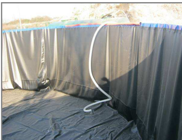
▼ Rejet dans la cuve de stockage de 220 m 3
