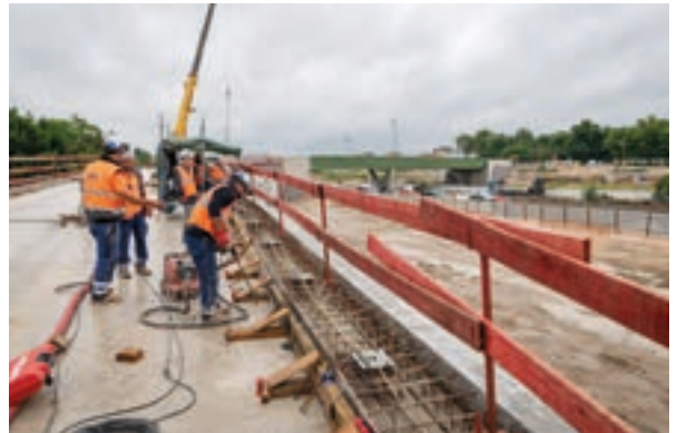
Réalisation de la nouvelle bretelle d'accès à l'A4 vers Paris depuis le nouveau pont
